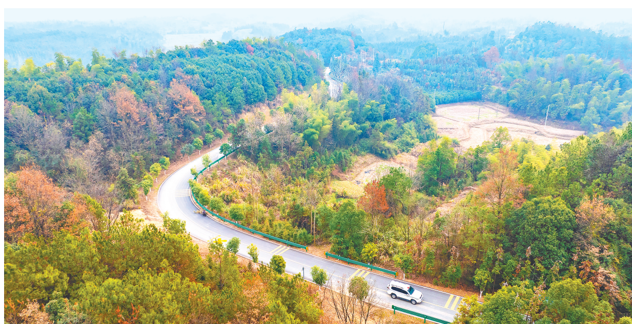
12月27日，航拍咸宁市咸安区“四好农村路”朱新线。（湖北日报全媒体记者 柯皓 摄）
