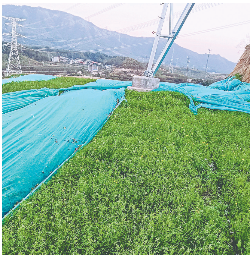
十一月二十八日,黄石变电站配套五百千伏送出工程铁塔下植被恢复情景。(湖北日报通讯员 占海歌 摄)
