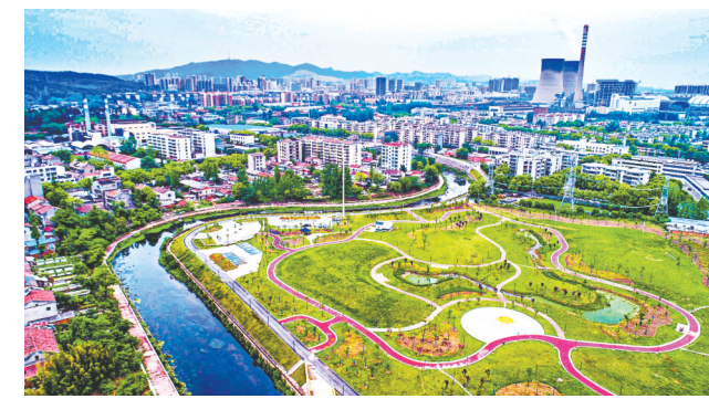
葛洲坝集团承建的湖北荆门竹皮河流域水环境综合治理项目。
