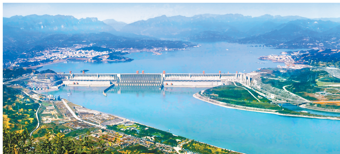
葛洲坝集团建设的三峡水利枢纽工程。
