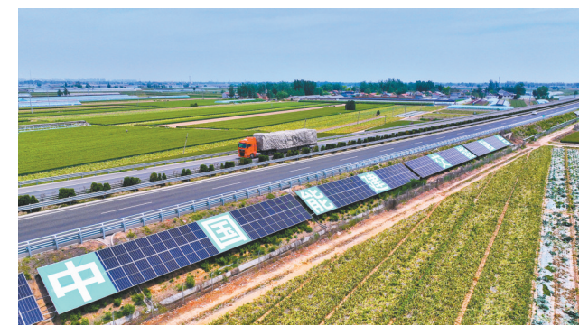
葛洲坝集团投资建设的山东枣菏高速公路交能融合示范工程。
