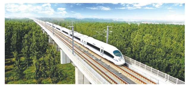
葛洲坝集团参与投资建设的汉宜高速铁路。
