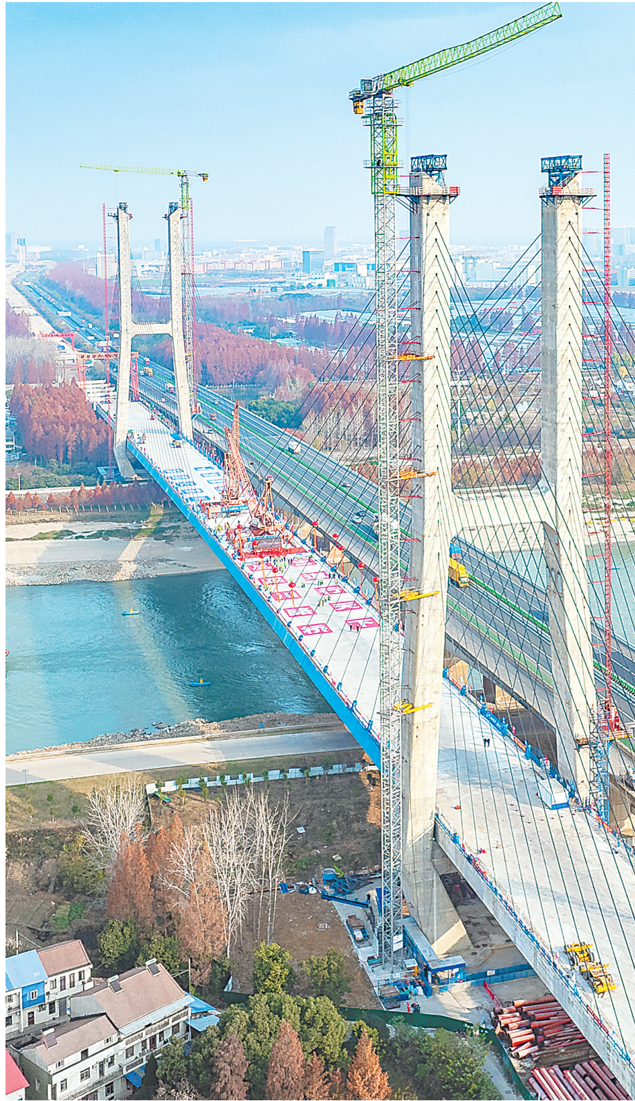
12月19日,京港澳高速湖北北段改扩建工程汉江特大桥合龙,标志着大桥主体工程的建设完成。(湖北日报全媒体记者 柯皓 摄)
