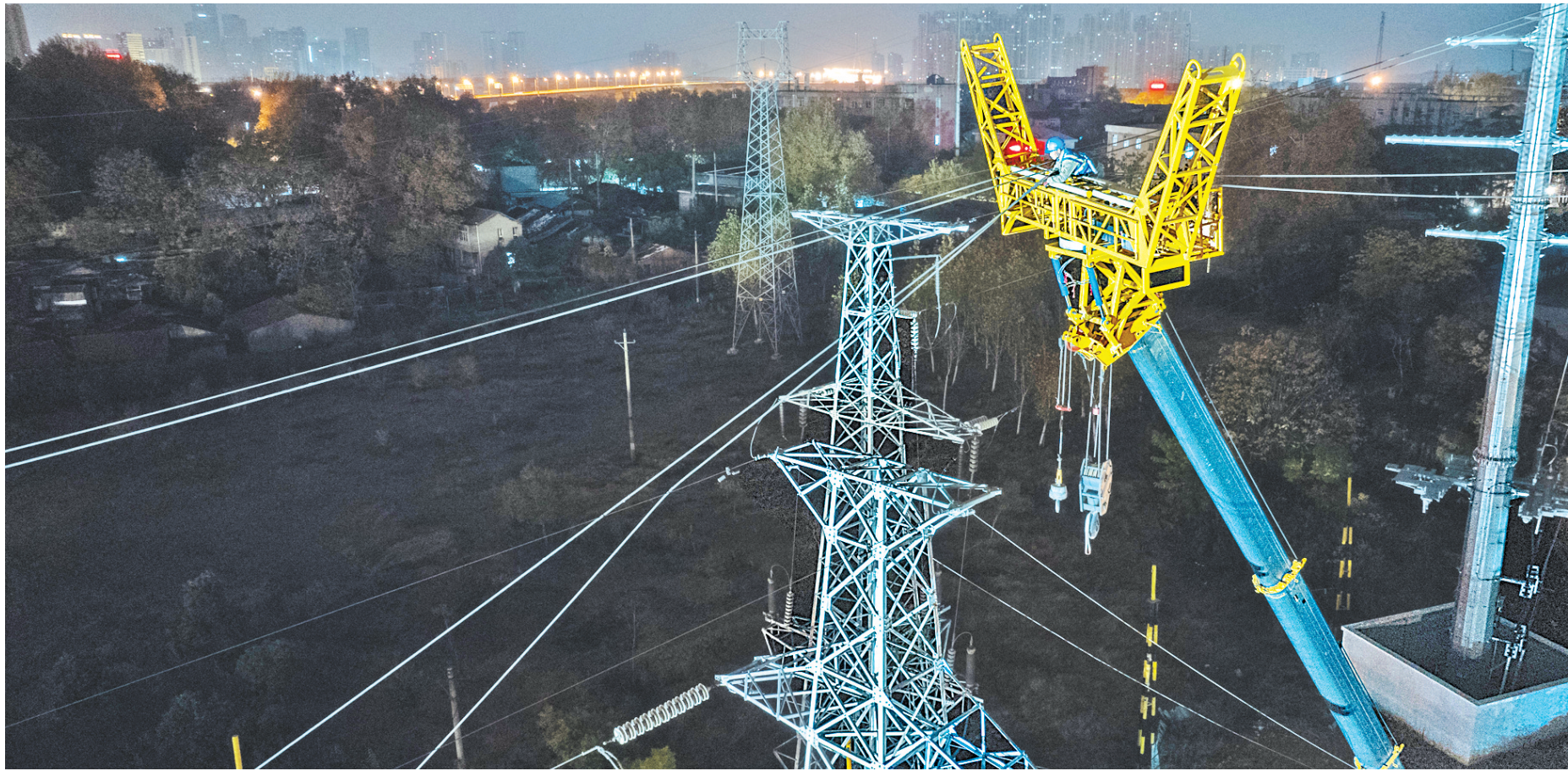
12月6日凌晨1时许,电力工人在高空进行跨友谊大道高压线拆除作业。(湖北日报全媒体记者 柯皓 摄)
