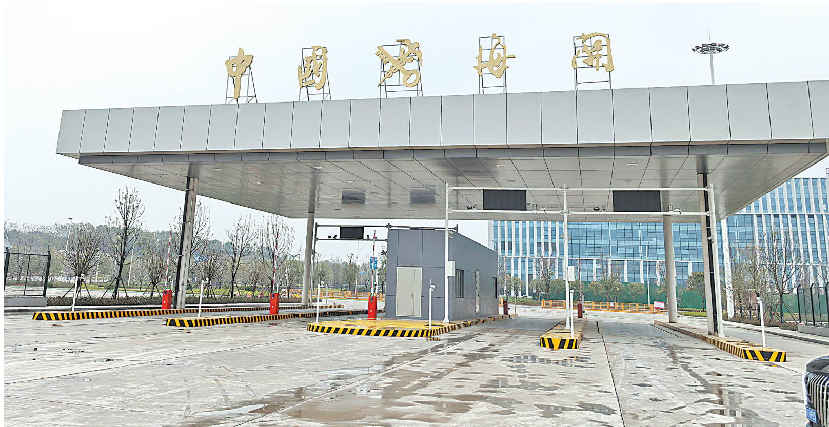
12月16日,鄂州空港综合保税区多功能仓储物流中心项目建成,海关已挂牌。
