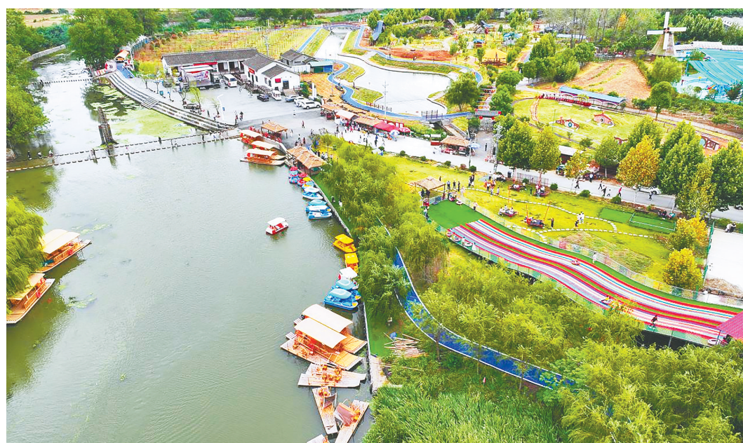
幸福鸢河项目建设实施后,鸢河村醉美鸢河景区生态环境大幅提升。(宣城市水利局供图)
