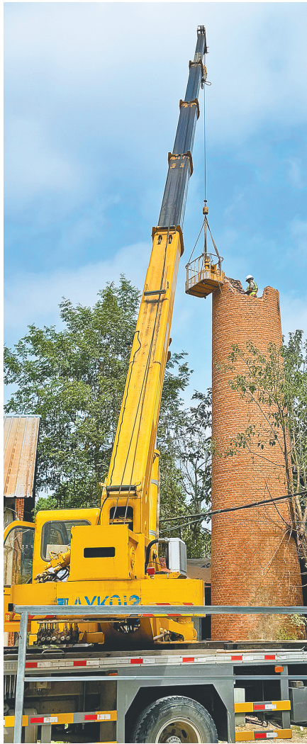
图为拆除现场。
