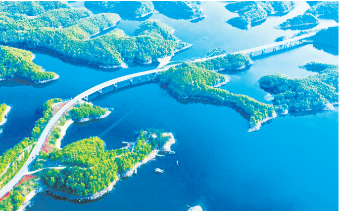
投放全省单笔最大的农发基础设施基金10亿元，投资联动审批贷款130亿元，支持南水北调中线引江补汉工程及配套建设，打通长江向北方输水通道，加速构建国家水网主骨架。
