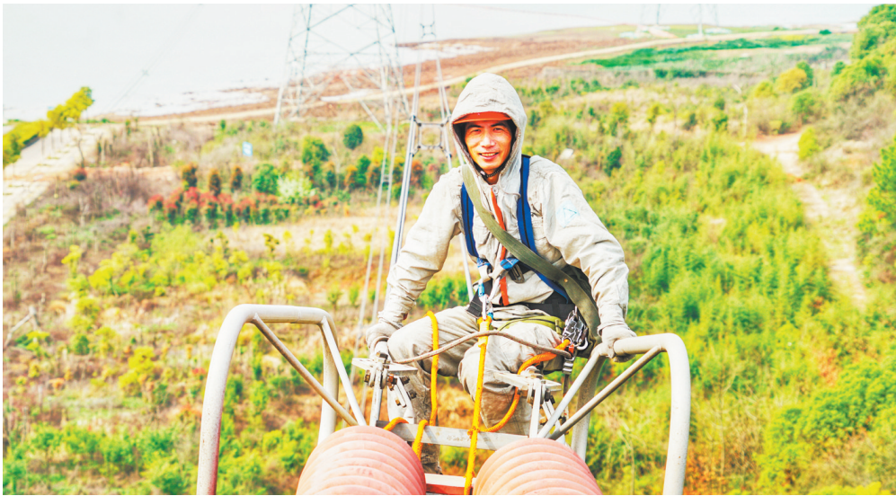
2020年3月10日,国网湖北超高压公司职工胡洪炜及时处理500千伏玉军线间隔棒脱爪的严重缺陷,图为完成作业后胡洪炜在塔上小憩。(于江 摄)
