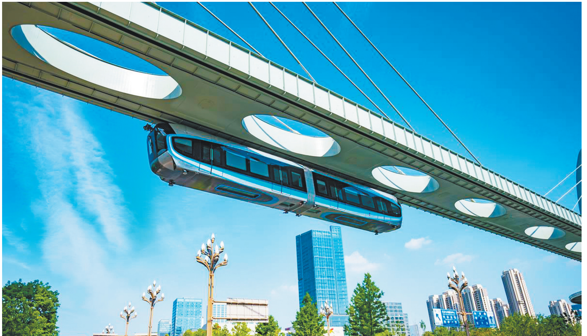
光谷空轨列车经过武汉高新大道路段。
