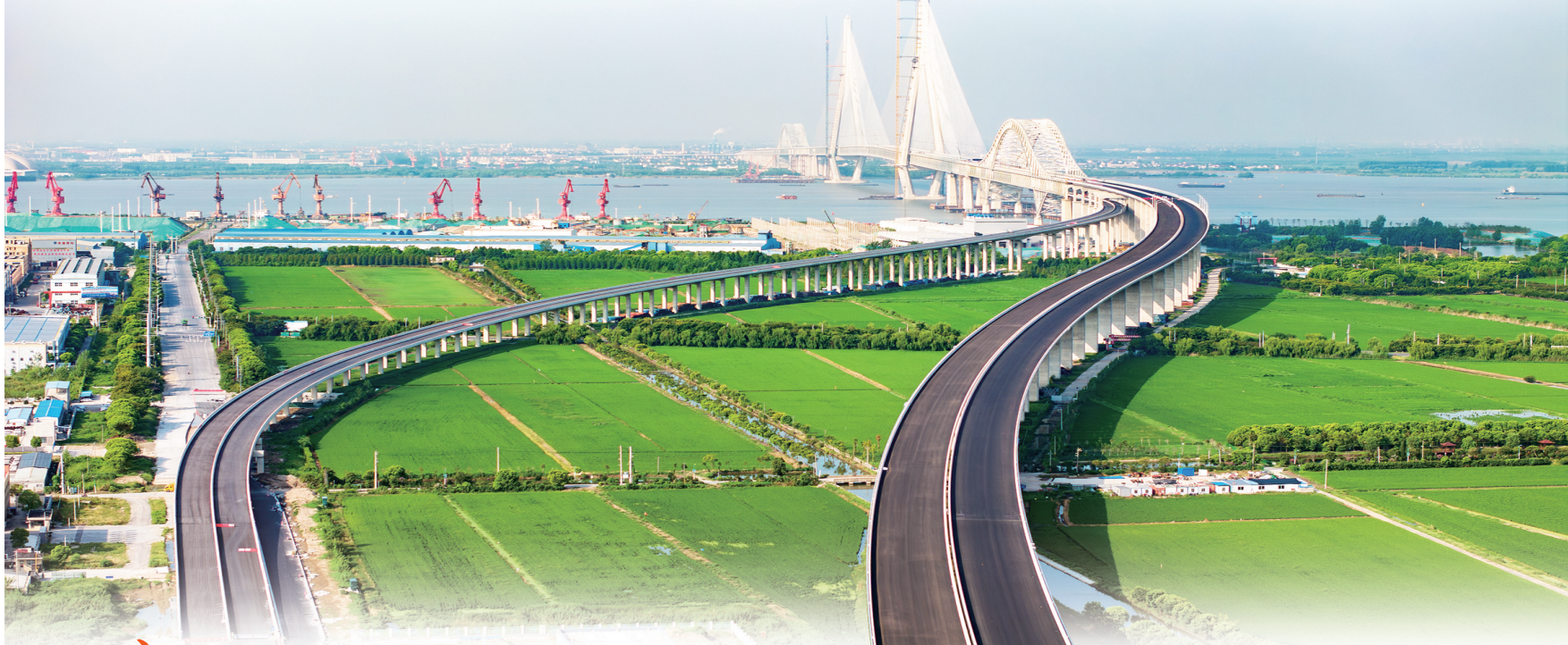
目前,常泰长江大桥正在进行桥面铺装施工。(赵振宇 摄)
