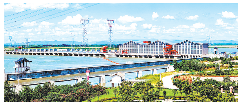
碾盘山枢纽工程全景(省碾盘山局供图)
