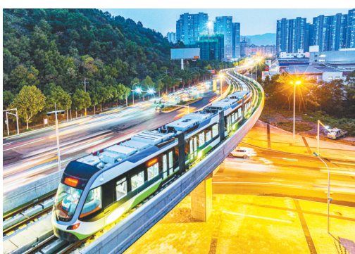
现代有轨电车串起黄石老城区和新区。
