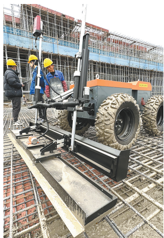
联投湖北建工首个工地机器人。
