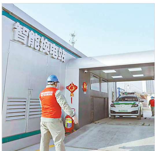
供电公司工作人员引导出租车进行智能换电操作。
