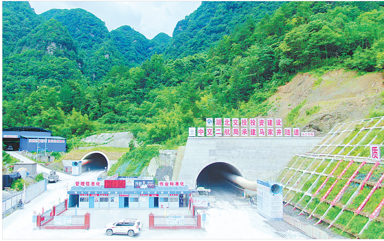
马家井隧道。贯通后的马家井隧道。
