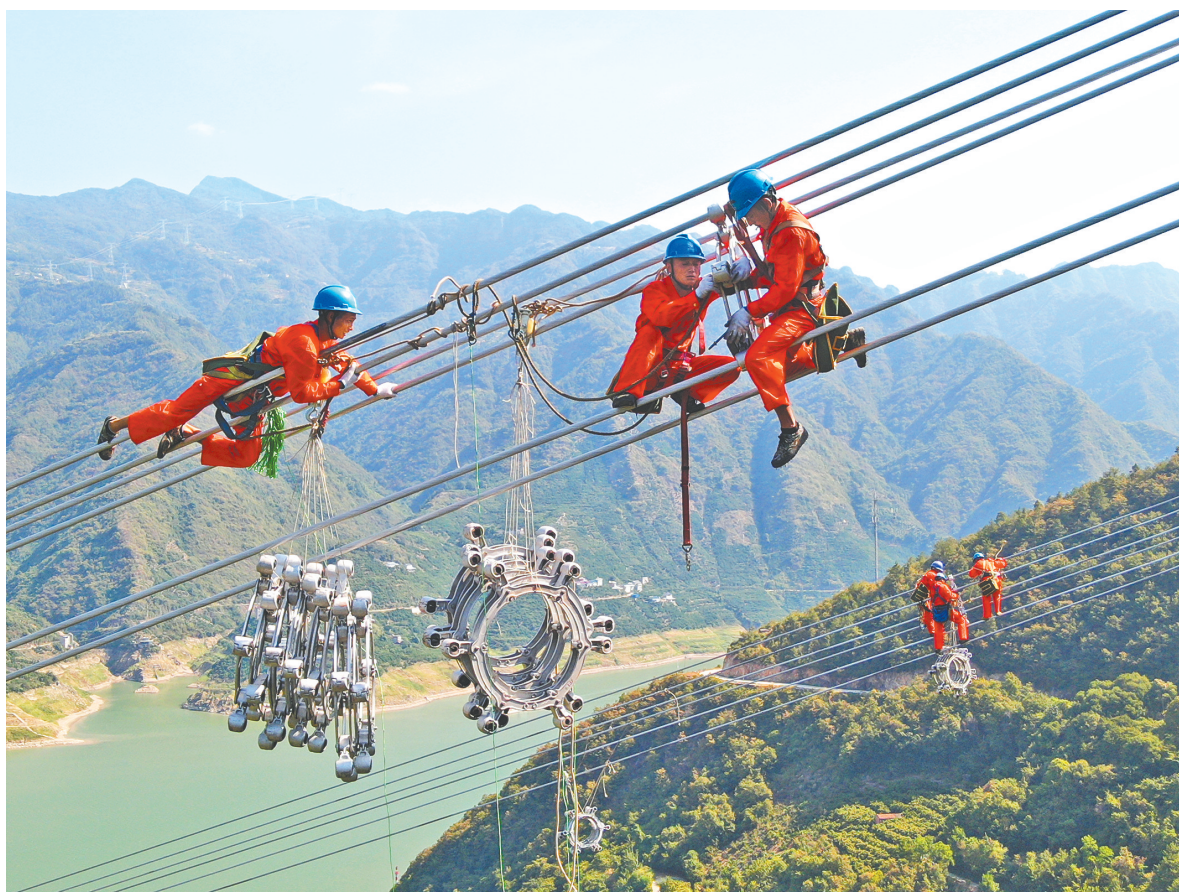
特高压建设者在白鹤滩—浙江特高压工程(湖北段)安装间隔棒。(国网湖北电力供图)
