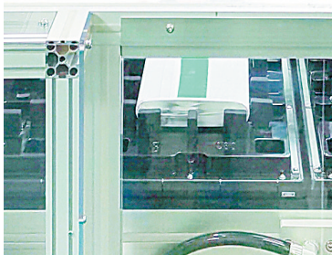
远景动力零碳智能电池产业园项目9号电芯车间。(湖北日报通讯员 金正 摄)
