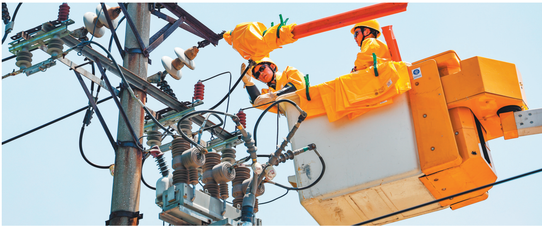
7月24日,国网武汉供电公司配网不停电作业中心女子带电作业班,身着绝缘服,进行人工带电作业抢修。
