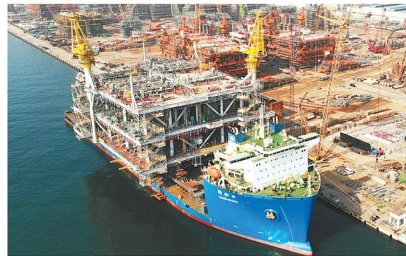
8月12日,由海洋石油工程(青岛)有限公司承建的沙特阿美马赞油气集输平台在山东青岛完工交付。该平台主要负责将开采出的海洋油气汇集并输送到陆地进行处理,每年可以汇集输送原油2400万吨、伴生气74亿立方米;平台重量超过17200吨,高度超过24层楼,甲板面积相当于约15个篮球场。图为当日即将发运的马赞油气集输平台。(新华社发)
