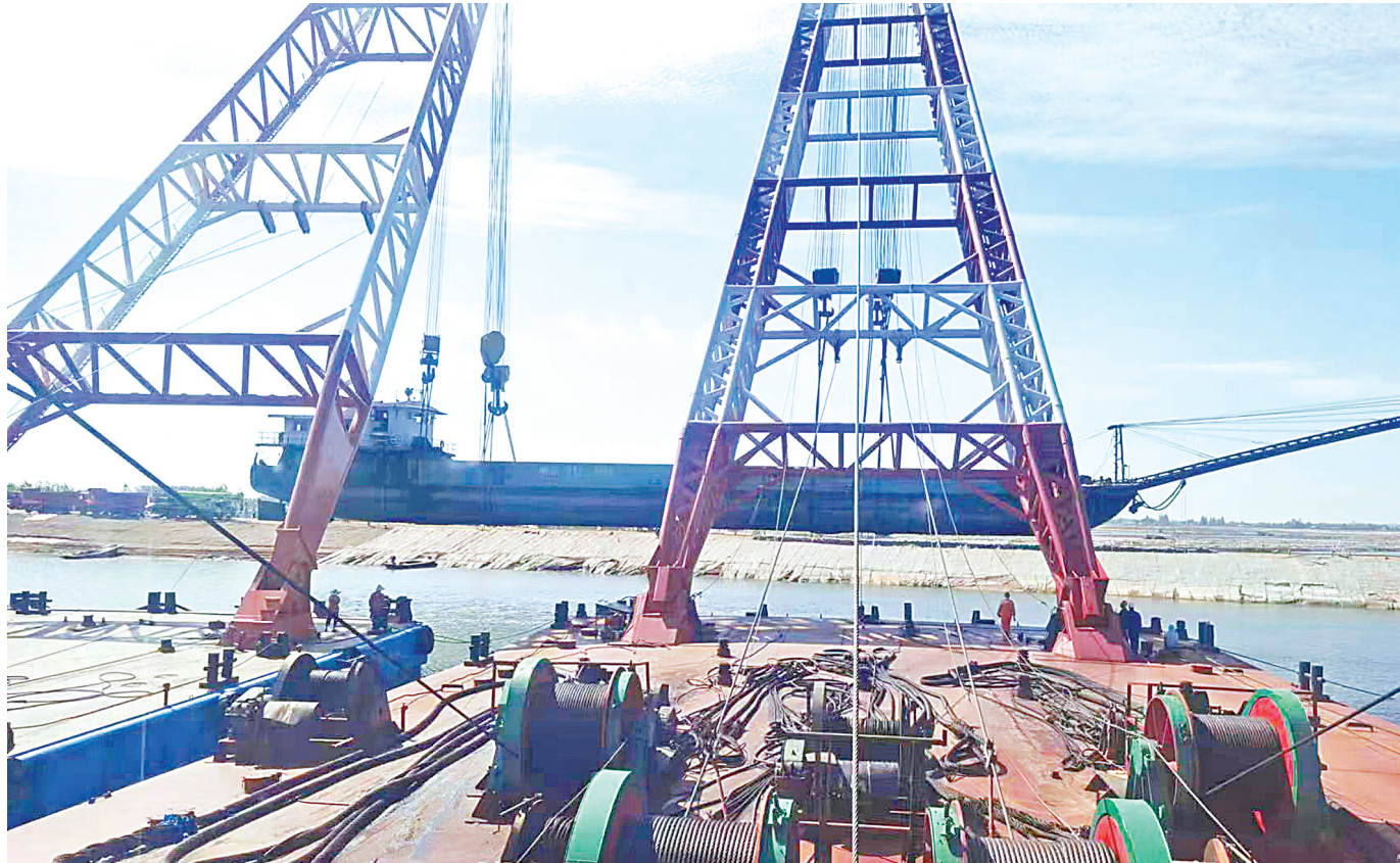
水位不断下降,意味着吊行跨度越来越大,救援难度越来越高。为了抢时间,大家冒着酷暑,挑灯夜战,进行船只固定和工
