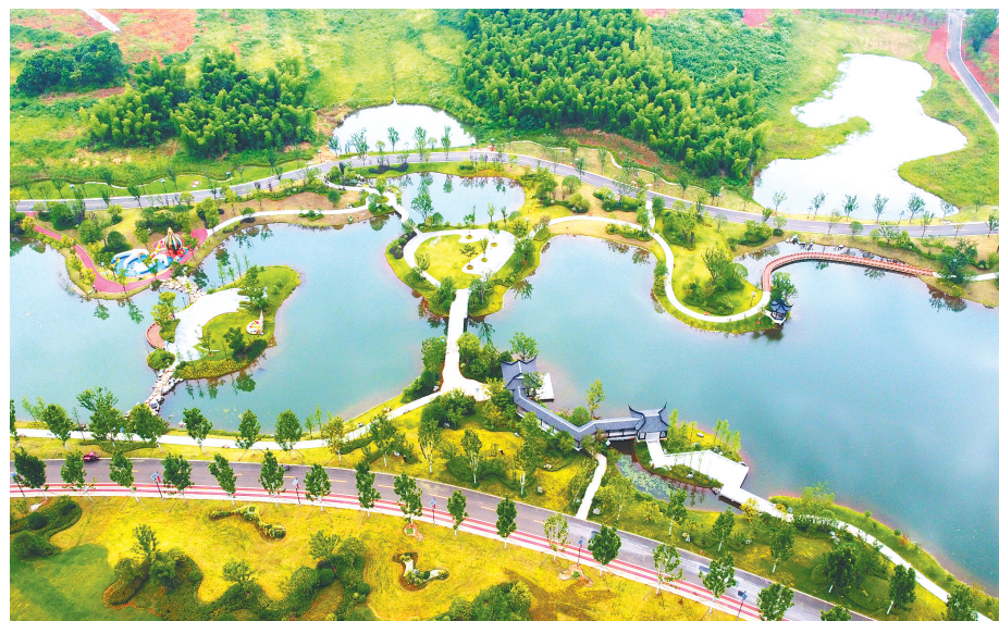
嘉鱼官桥对南城小镇进行生态修复。(嘉鱼县自然资源和城乡建设局供图)
