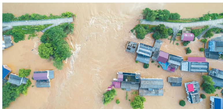
29日拍摄的涓水湘潭县河口镇华中村堤段决口险情现场。
