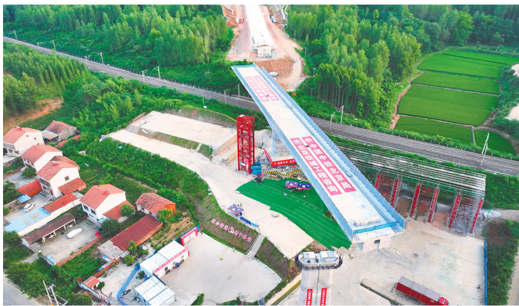
桥梁转体现场。
