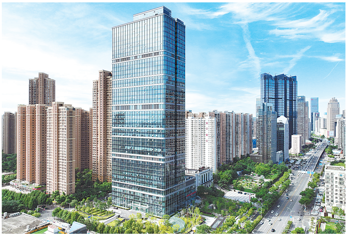
位于武昌中北路的长江产业大厦。(湖北日报全媒记者 柯皓 摄)
