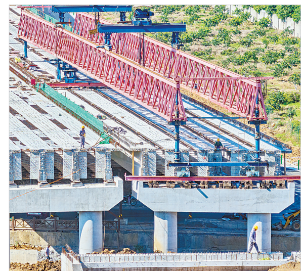
7月22日,在宜昌市S254宜都绕城中段及红花套镇绕镇段项目现场,工人们正在大桥及互通段加紧施工。S254宜都绕城中段及红花套镇绕镇段项目全长22.1公里,预计2025年5月前正式通车。(湖北日报全媒体记者 刘曙松 通讯员 朱灿义 摄)
