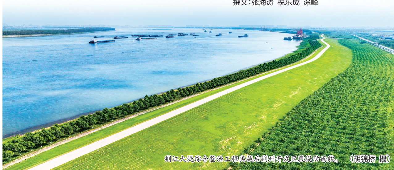
漳河水库除险加固工程鸡公尖主坝施工现场。
