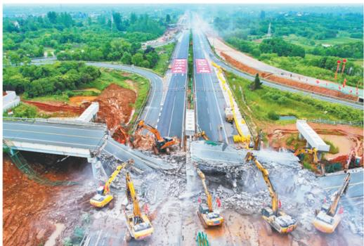
6月30日，京港澳高速孝昌段，大型机械正在进行跨线桥拆除作业。（湖北日报全媒体记者 柯皓 通讯员 吴迪 摄）
