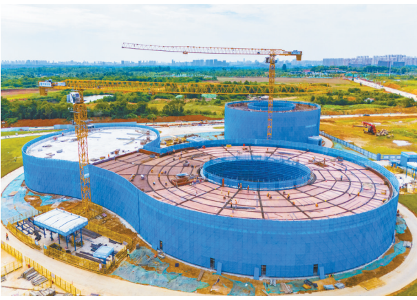
深部岩土工程扰动模拟设施大科学装置即将主体工程。(魏铤 摄)
