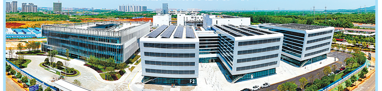
即将投产的武汉光迅科技股份有限公司高端光电子器件产业基地俯瞰。(湖北日报全媒体记者 魏铨 摄)
