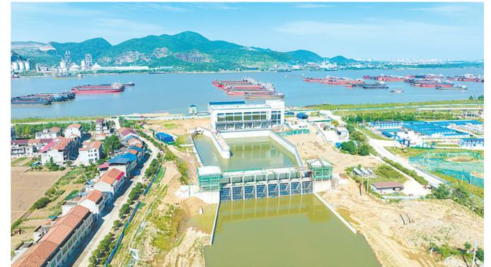
6月3日,乌瞰阳新县富池二站新建工程,目前项目6台机组调试完毕,正在进行装饰装修工作。该工程是我省水利补短板三年行动的重要项目,投资4.5亿元。项目建成后,将大幅提高网湖分洪区的排江能力,有效缓解富河流域堤防压力。
