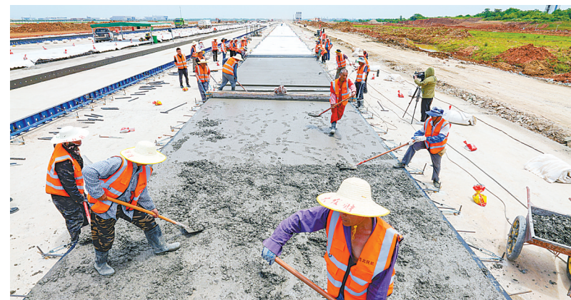
6月3日,在武汉天河机场第三跑道工程现场,机器轰鸣作响,工人们正在加紧施工。(湖北日报全媒体记者 倪娜 通讯员 习悦 蔡思聪 摄)
