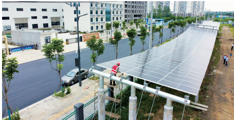
建行武汉钢城支行为湖北某电力设计有限公司提供“善新贷”780万元,支持该公司在湖北、江苏、海南、广西等地的柔性光伏支架项目建设。图为该公司正在建设的位于黄冈市的柔性光伏支架项目。
