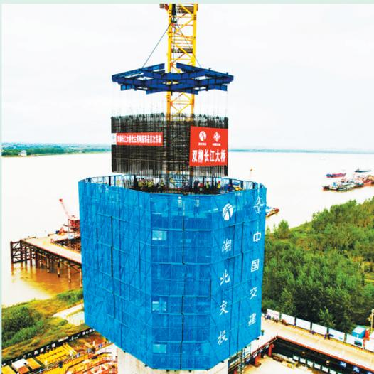
2023年9月30日,双柳长江大桥北岸主塔首节钢混部品成功吊装。
