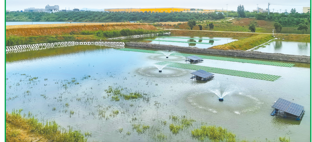
新修的养殖尾水生态处理设施。
