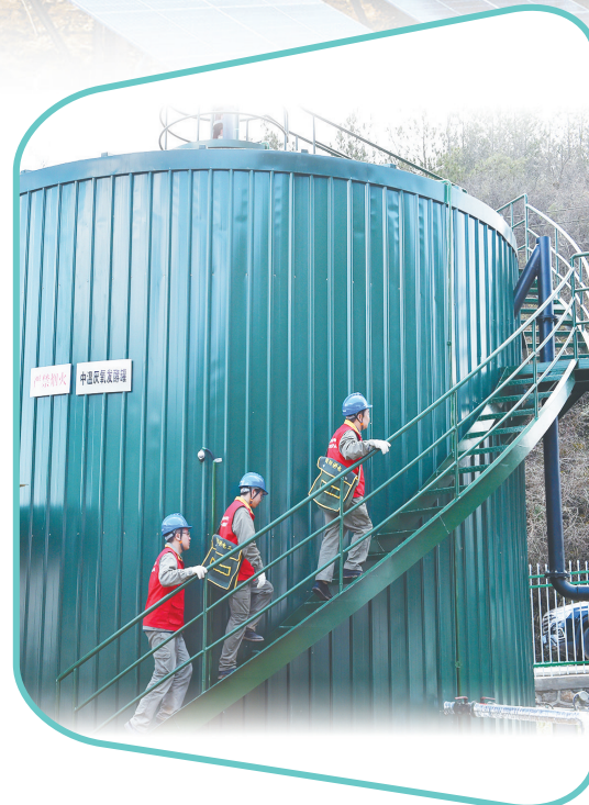
国网湖北电力员工在巴东县信陵镇土店子村巡检沼气发电站。
