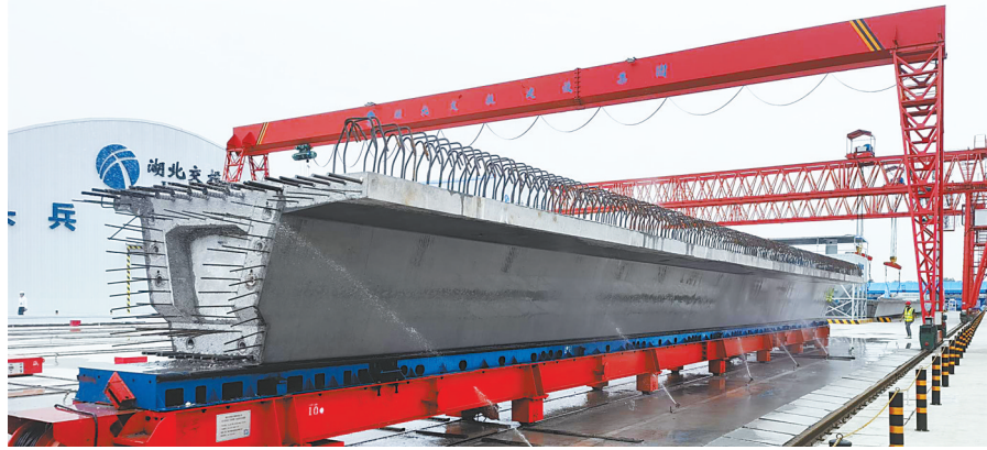
智慧梁厂的喷淋系统在给箱梁降温养护。
