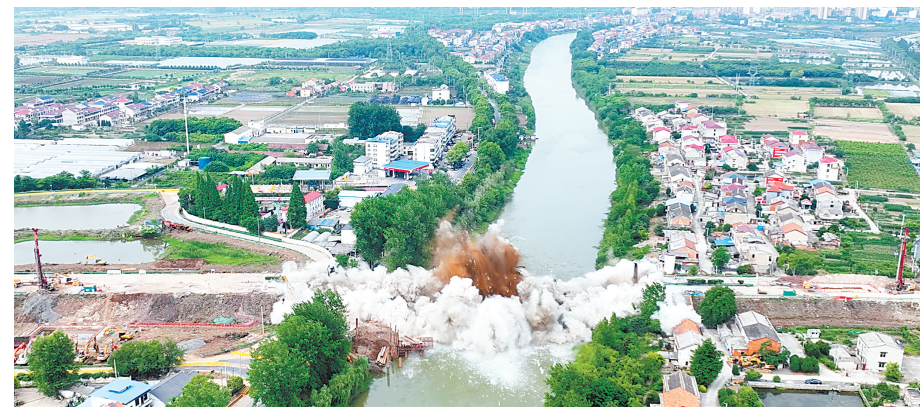
5月19日,武黄高速改扩建项目柯家墩大桥成功实施爆破瞬间。(湖北日报全媒记者 柯皓 摄)
