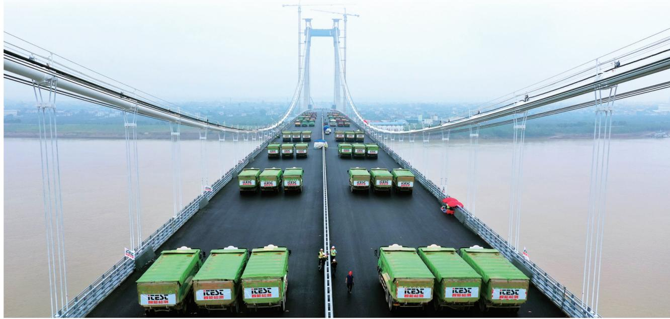
宜昌长江公路大桥主桥荷载试验。
