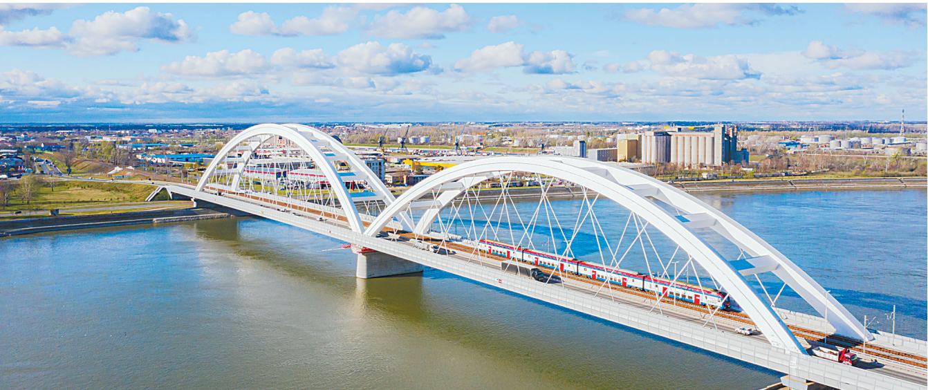
2024年3月12日,一列火车运行在匈塞铁路塞尔维亚境内贝诺段诺维萨德多瑙河大桥上。(新华社发)
