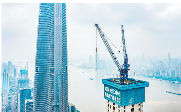
5月5日,施工中的武汉长江中心项目塔楼直插云霄,与毗邻的武汉绿地中心大厦遥相呼应。4月7日,武汉长江中心项目塔楼高度突破300米,项目完工后总高约380米。该项目应用了中建三局自主研发的湖北省首台第四代“空中造楼机”轻量化顶模集成平台,2.5小时即可完成4.4米标准层的顶升作业,4天可完成一个结构层整体施工,效率相较以往提升20%以上。
