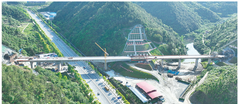
二田沟与跨汉江大道大桥浇筑最后一段现浇梁。(湖北日报通讯员 冉欧阳 摄)
