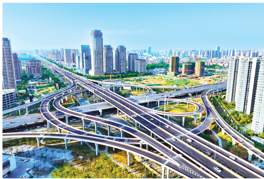
4月26日,车辆在襄阳环线提速改造工程云兴互通立交桥上通行。(湖北日报通讯员 谢勇 张沛 摄)
