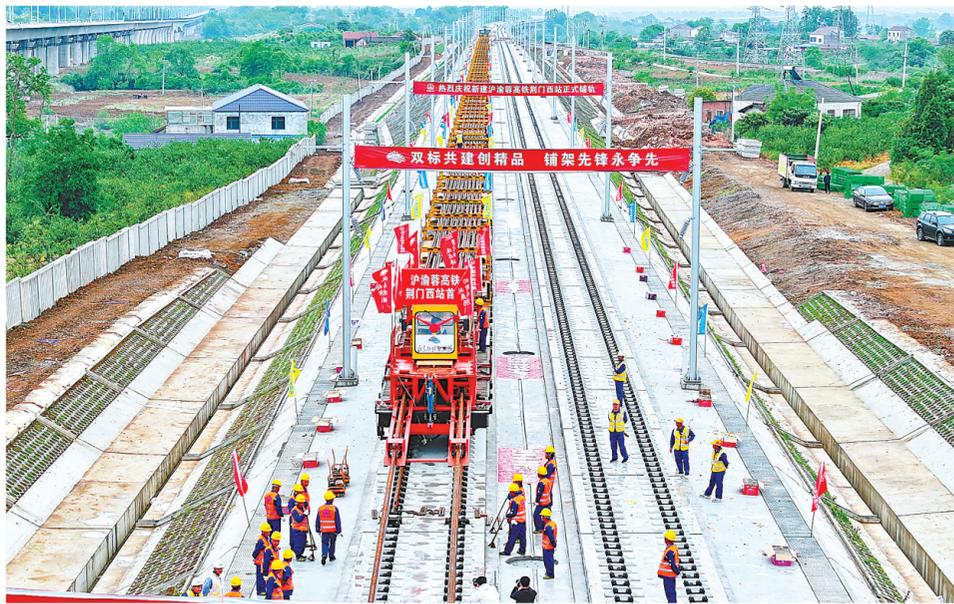
湖北日报讯(记者林晶、胡祎、通讯员周祁煜、马立)4月16日,在沪渝蓉高铁(简称“沿江高铁”)武宜段荆门西站施工现场,在牵引机车的牵引下,中铁四局多功能长钢轨铺轨机组如一条长龙躺卧,缓缓“吐出”一对500米长钢轨,稳稳地铺设在无砟轨道床上。这标志着沿江高铁武宜段开始铺轨施工,进入建设冲刺阶段。
