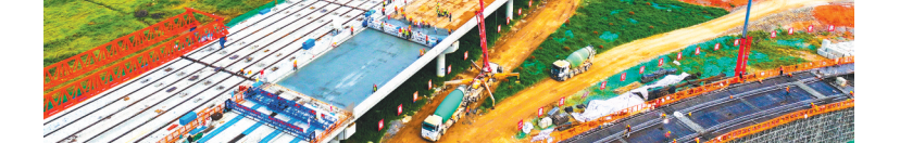
双柳长江大桥郢城西互通桥面铺装现场。(湖北日报全媒体记者 田悦 通讯员 刘若梅 摄)
