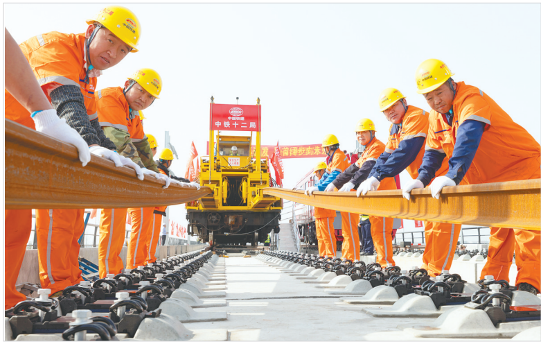
中铁十二局工人参加铺轨作业。（湖北日报全媒体记者 柯皓 通讯员 付振 摄）
