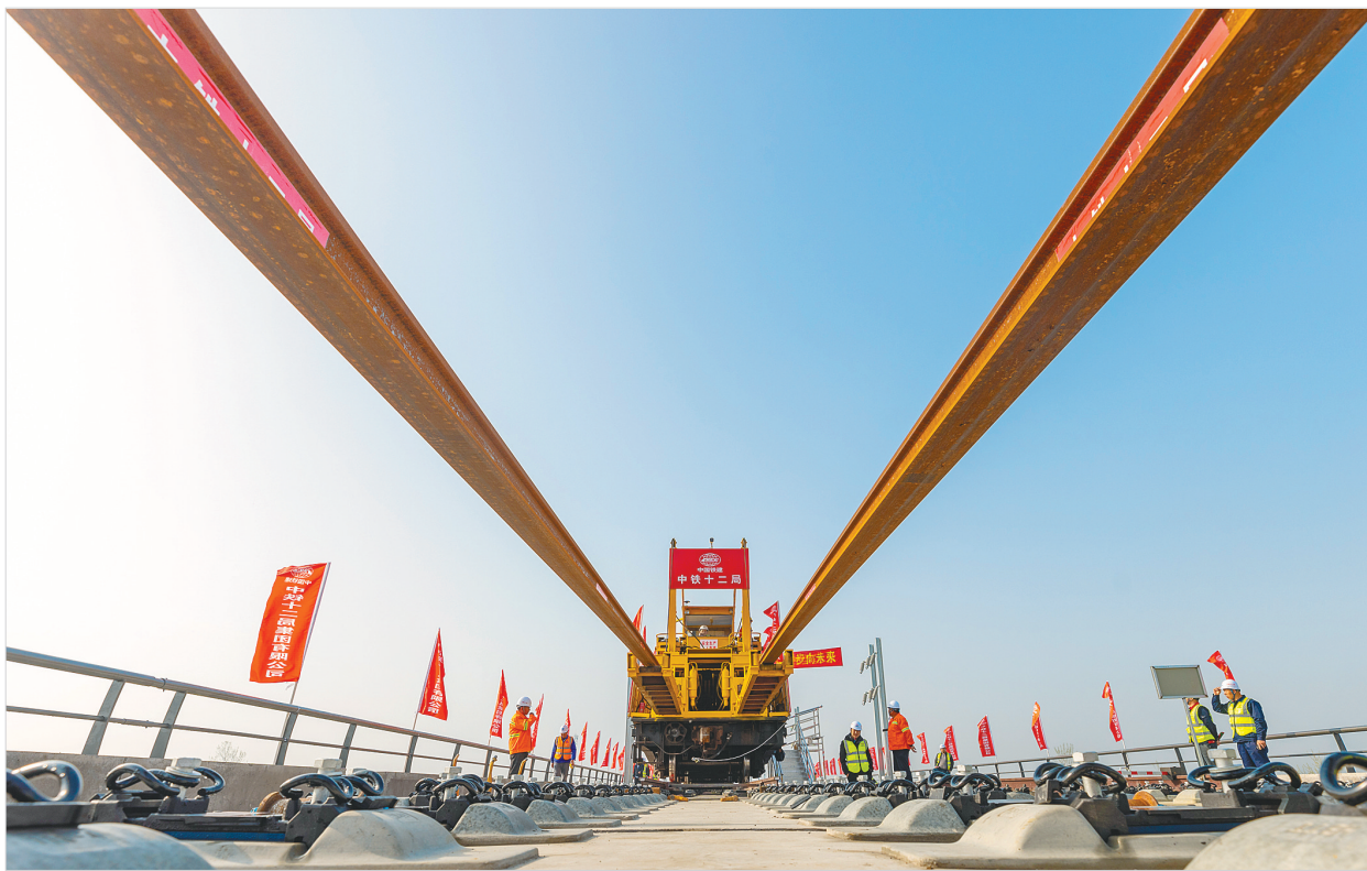
3月28日，TC-500型铺轨机“吐”出500米长钢轨。（湖北日报全媒体记者 柯皓 通讯员 付振 摄）
