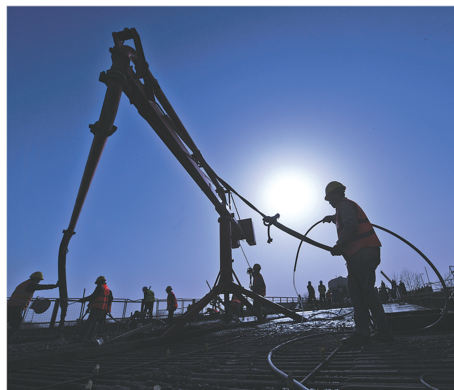
3月19日,建设者在沪渝蓉高铁钟祥汉江特大桥进行主桥首墩边跨混凝土浇筑。
