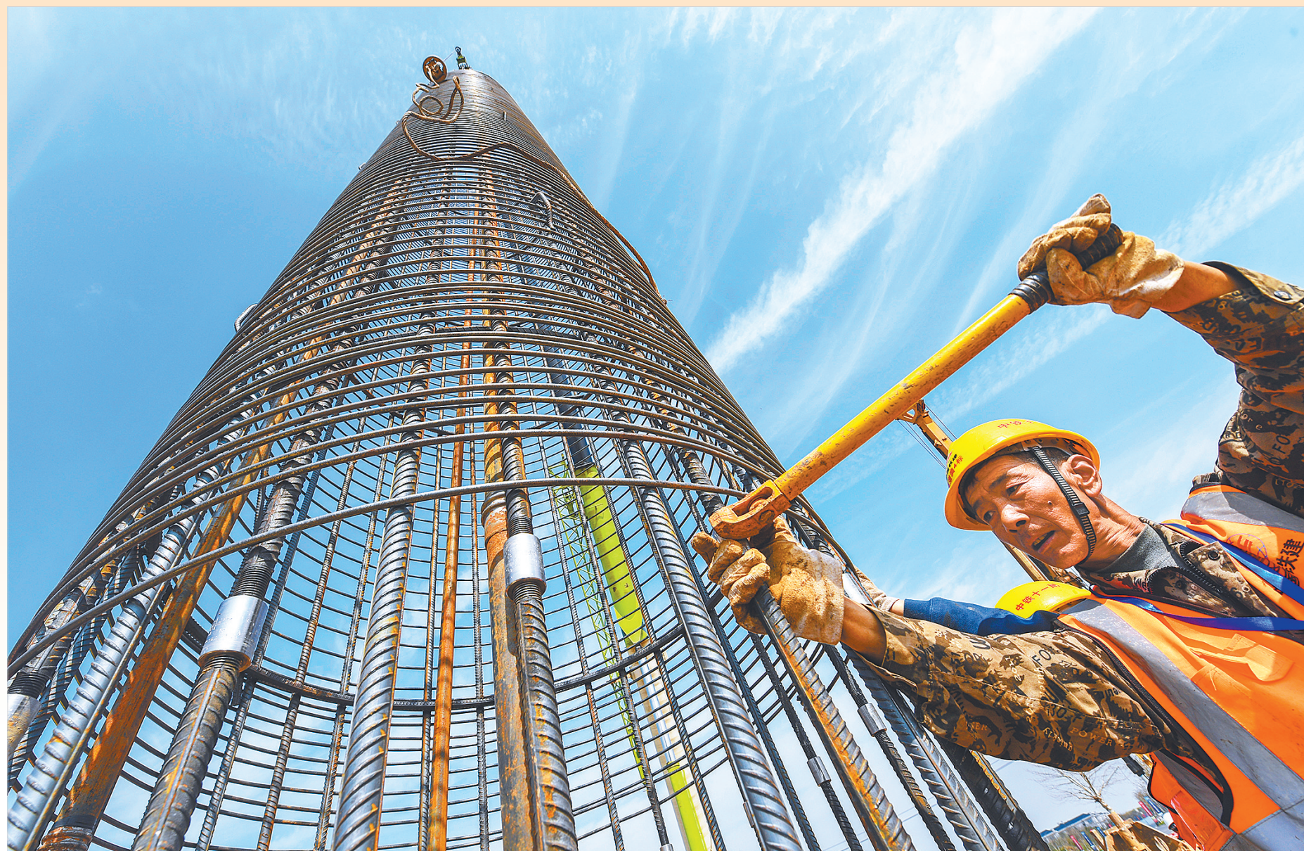
3月26日,京港澳高速公路改扩建工程新建孝感东互通收费站现场,一名工人实施钢筋笼下放作业。
