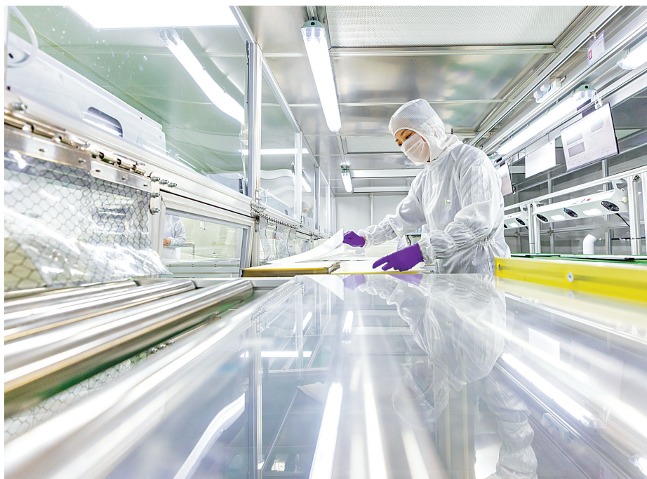
形辉科技天门有限公司 LCM 无尘车间内,工人正在加紧安装显示模组。(湖北日报全媒体记者 柯皓 通讯员 刘银斌 摄)
