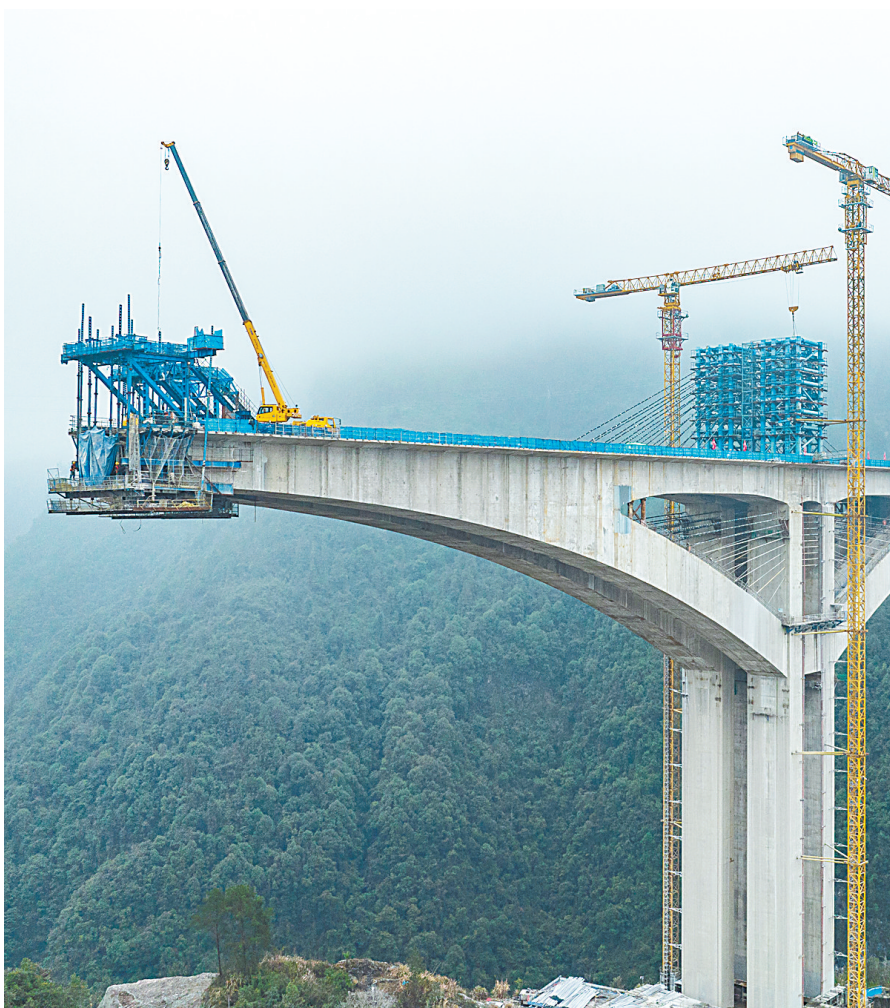
3月10日，工程建设者在鹤峰云南庄特大桥项目加紧作业。该桥是宜来高速鹤峰东段的控制性工程之一，总长1100米。（湖北日报全媒记者 柯皓 摄）
