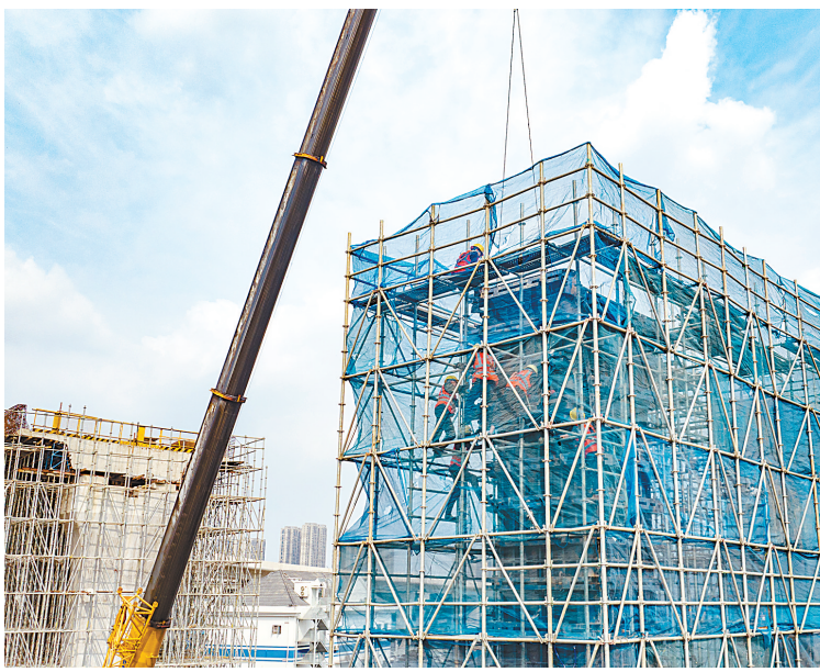
工人在改造提升的G107国道武汉市东西湖段高架施工。（湖北日报全媒记者 柯皓 摄）
